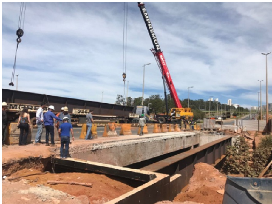
Alargamento de Pontes e Viadutos – Lançamento das Vigas – Ponte Corr. Samambaia (2018)
