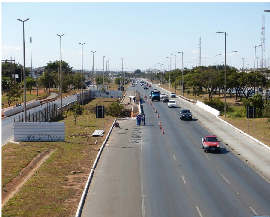
Alargamento de Pontes e Viadutos – Sinalização sobre a FCA (2018)
