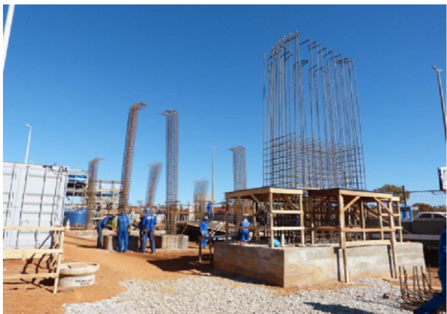
Passarela nº 6 (EPCL) – Obra de Implantação (2018)
