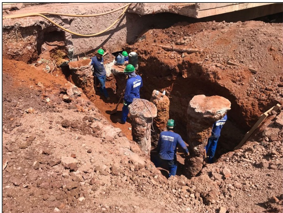
Alargamento de Pontes e Viadutos – Estacas – Ponte Corr. Samambaia (2018)
