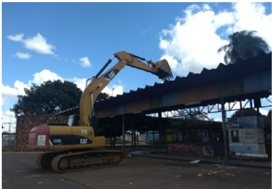
Terminal de Sobradinho Centro – Demolição da Cobertura (2018)
