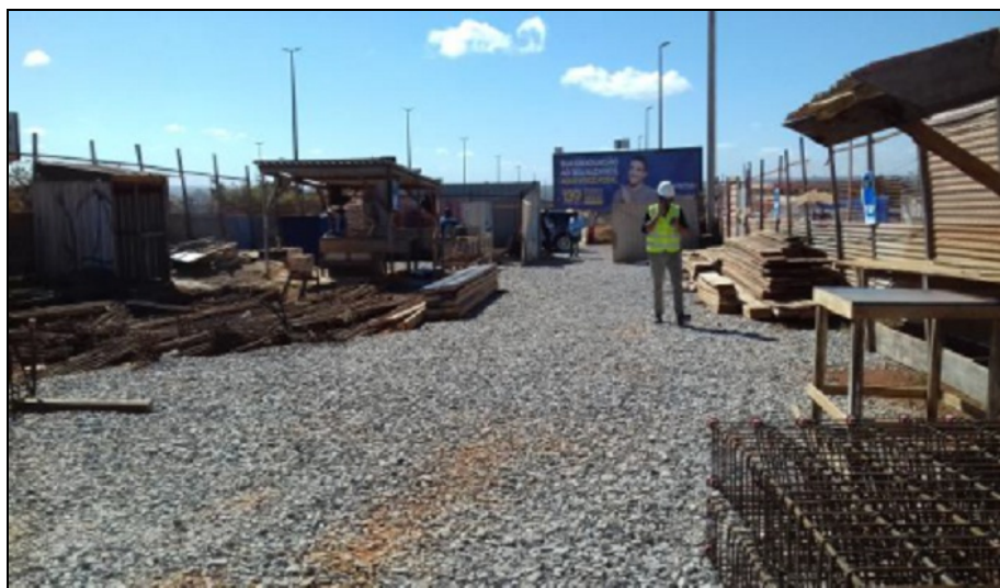
Passarela nº 6 (EPCL) – Canteiro de Obras (2018)
